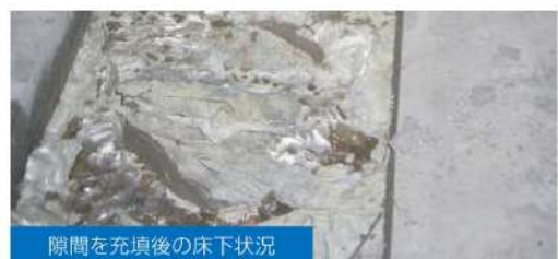
隙間を充填後の床下状況
