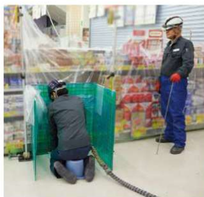
店舗での施工の様子
