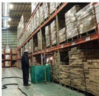
物流倉庫での施工の様子
